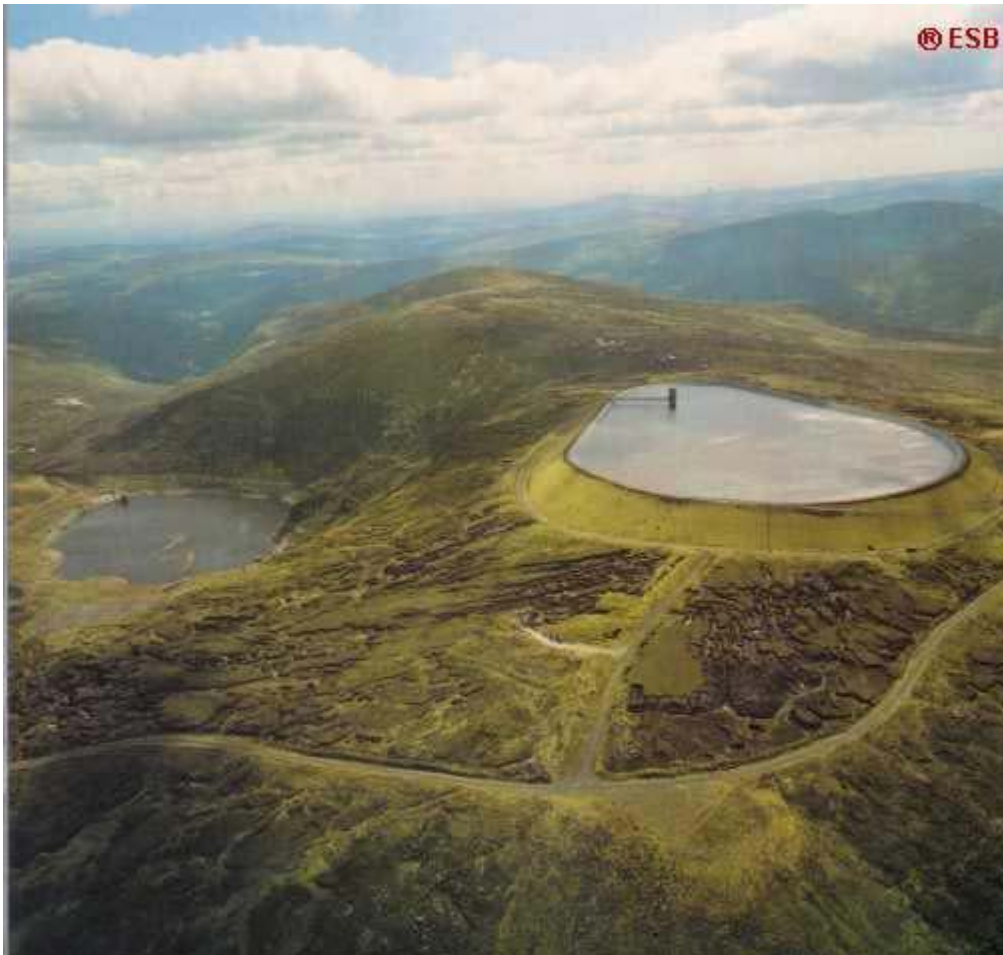
Σχήμα 1 Σύστημα αντλησιοταμιευτήρων στην περιοχή Turlough Hill, Wicklow της ανατολικής Ιρλανδίας
